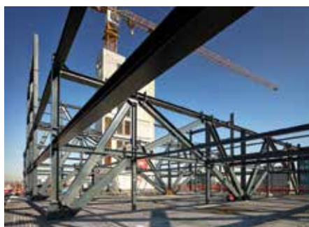
10. Spiderconstructie tijdens montage.
