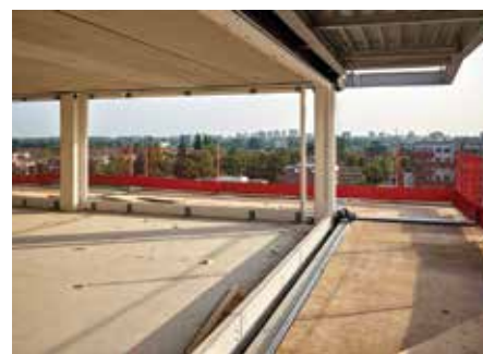
11. Woontoren met balkons gemonteerd.
