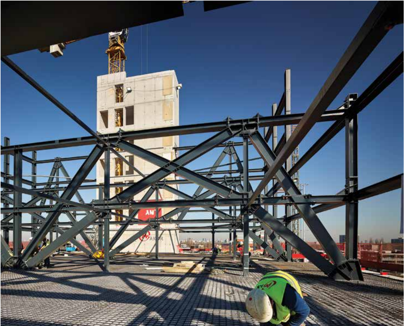
Spiderconstructie bekeken vanaf de 6e verdieping met de betonkern erachter.
