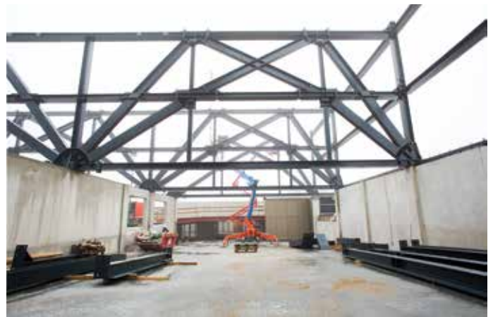
Spiderconstructie gezien vanuit de parkeergarage.
