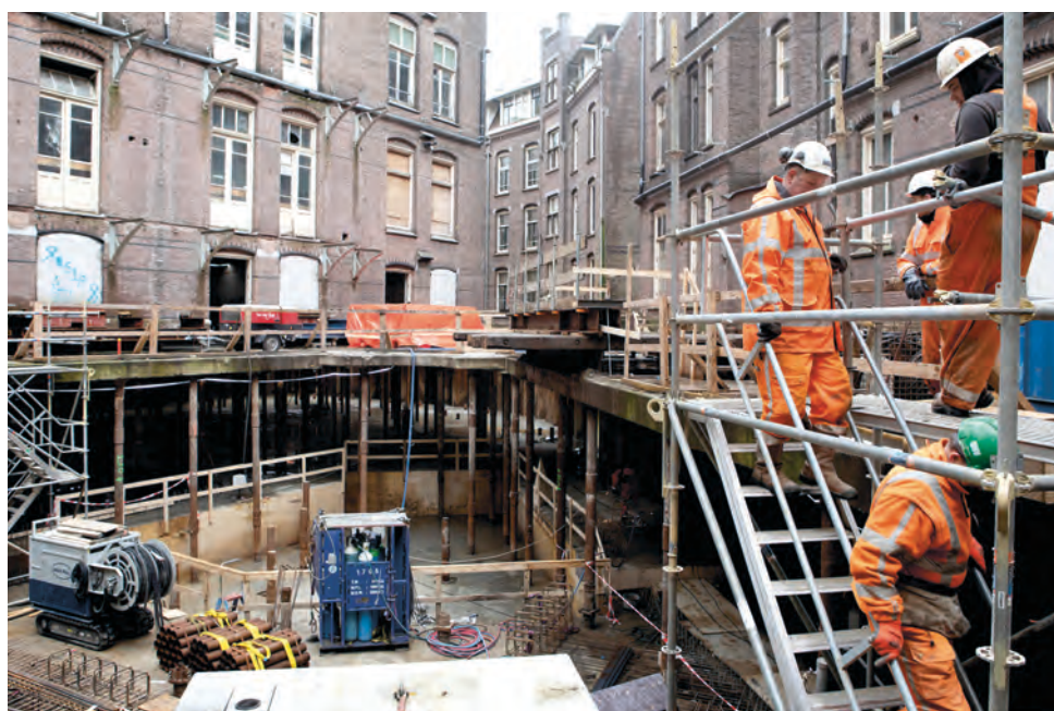
4 Bouw van een gewapend betonnen kelder in een doolhof van stalen palen en hulpconstructies
